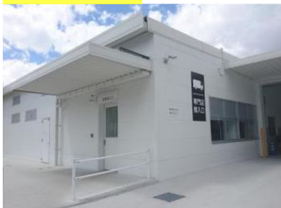
防災センター／入店口
